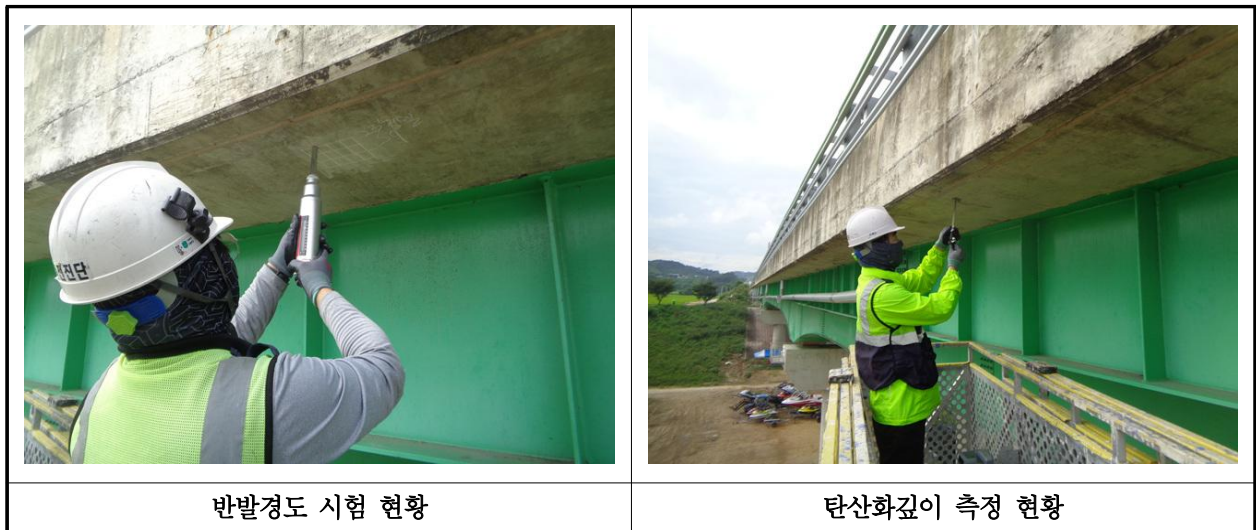
【사진 5.4.1】 콘크리트 내구성조사 현황
