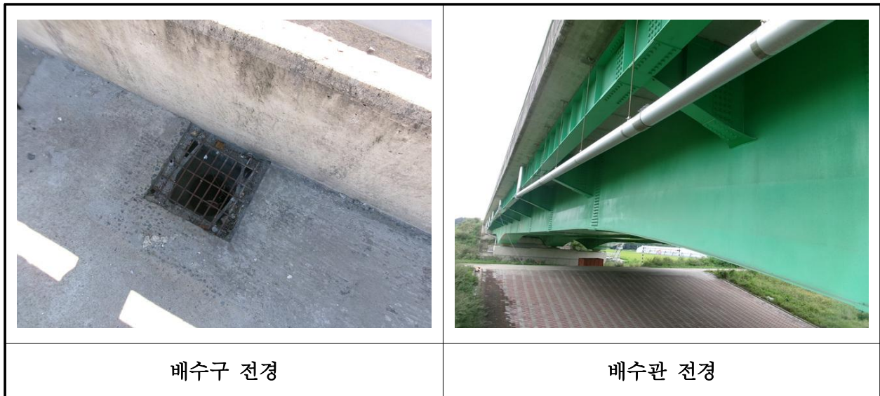
【사진 5.3.21】 배수시설 전경
