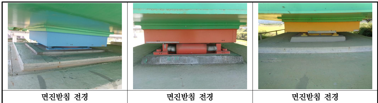
【사진 5.3.12】 교량받침 전경
