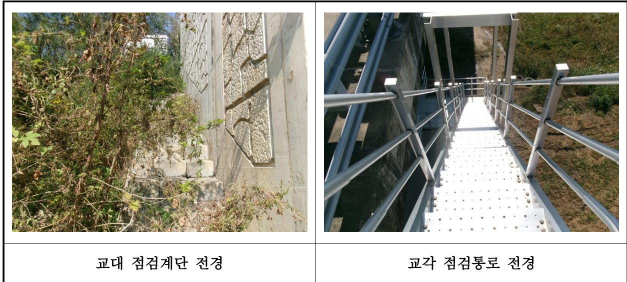
【사진 5.3.25】 교량 점검시설 전경
