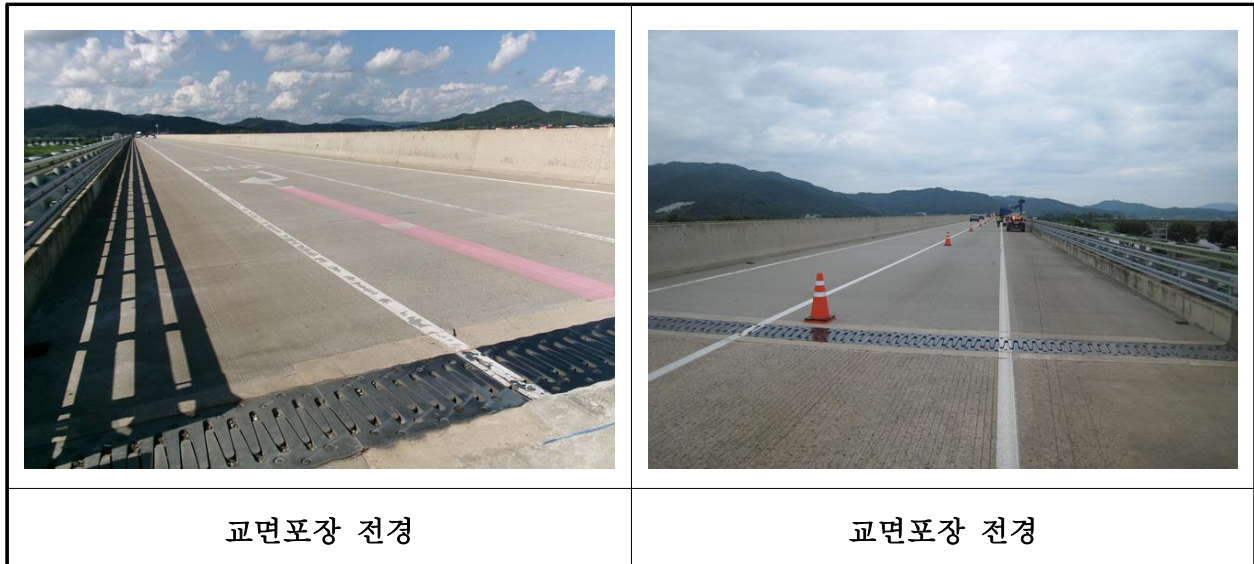
【사진 5.3.19】 교면포장 전경
