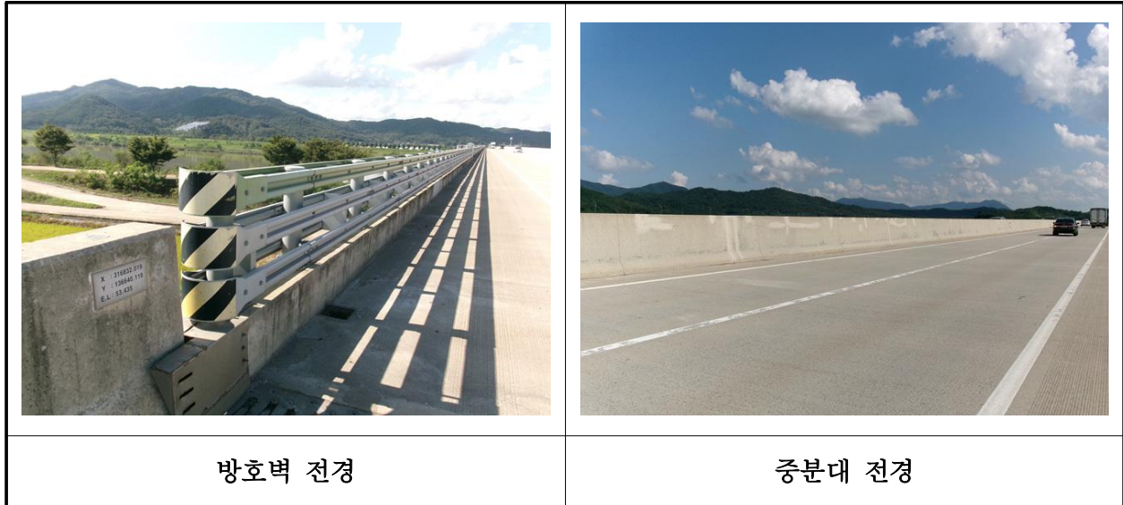
【사진 5.3.23】 방호벽 및 중앙분리대 전경
