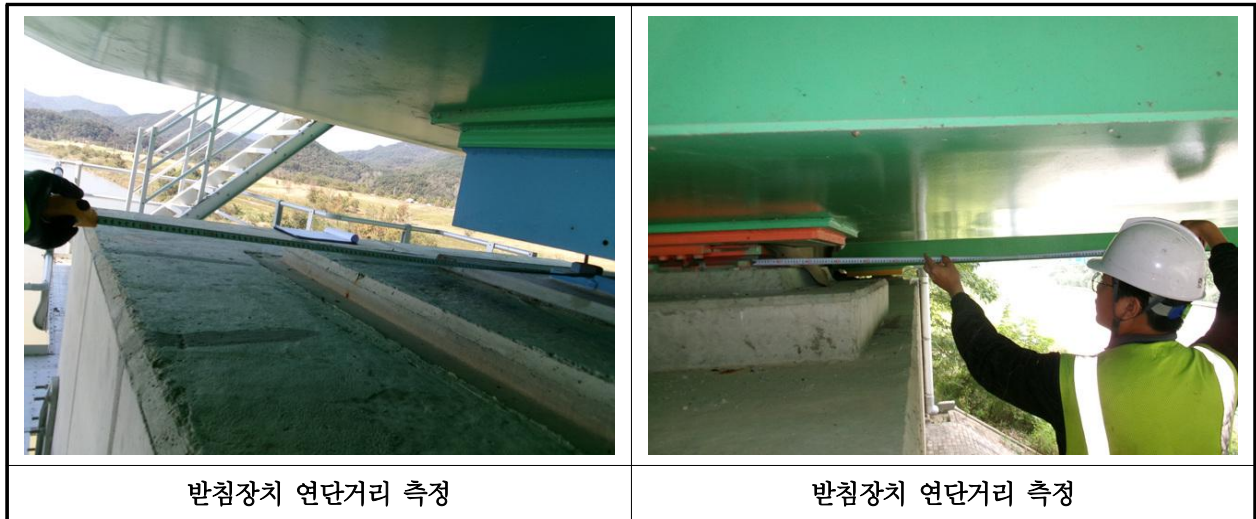
【사진 5.3.14】 교량받침장치 연단거리측정
