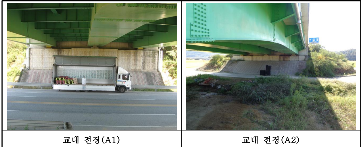
【사진 5.3.8】 교대 전경
