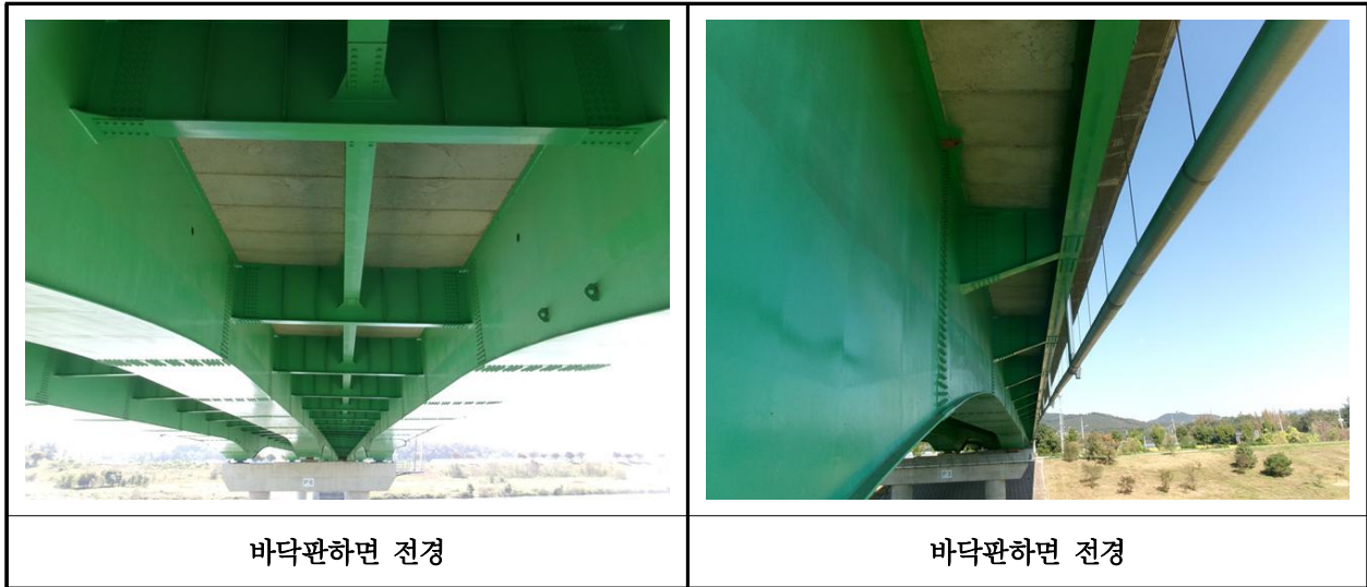
【사진 5.3.2】 바닥판하면 전경
