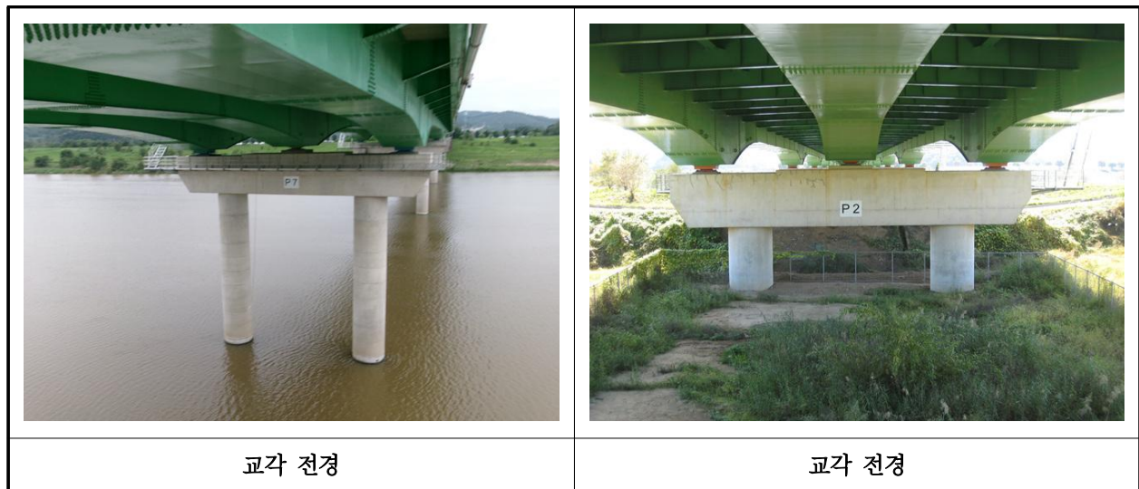
【사진 5.3.10】 교각 전경
